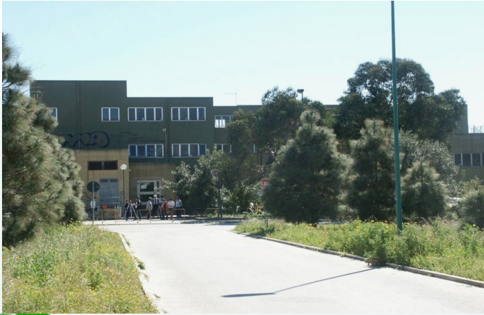
Sede centrale in via Cabras a Monserrato
